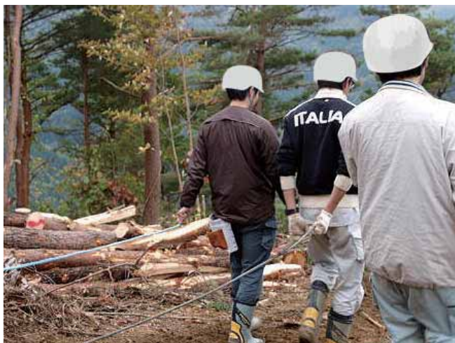
現場で繊維ザイルとワイヤーを引き出す (左端の人が引いているのが繊維ザイル)
