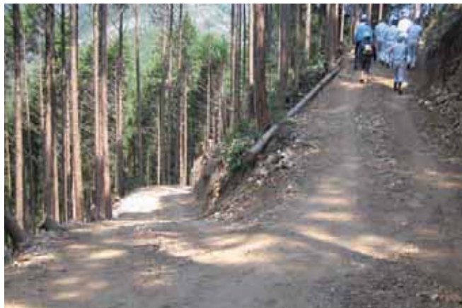
作業路開設などの土木工事には建設会社の技術力が生かされる
