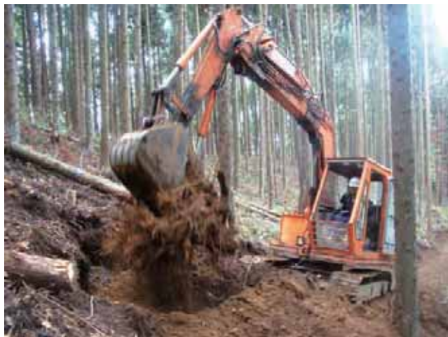
作業路の開設作業
