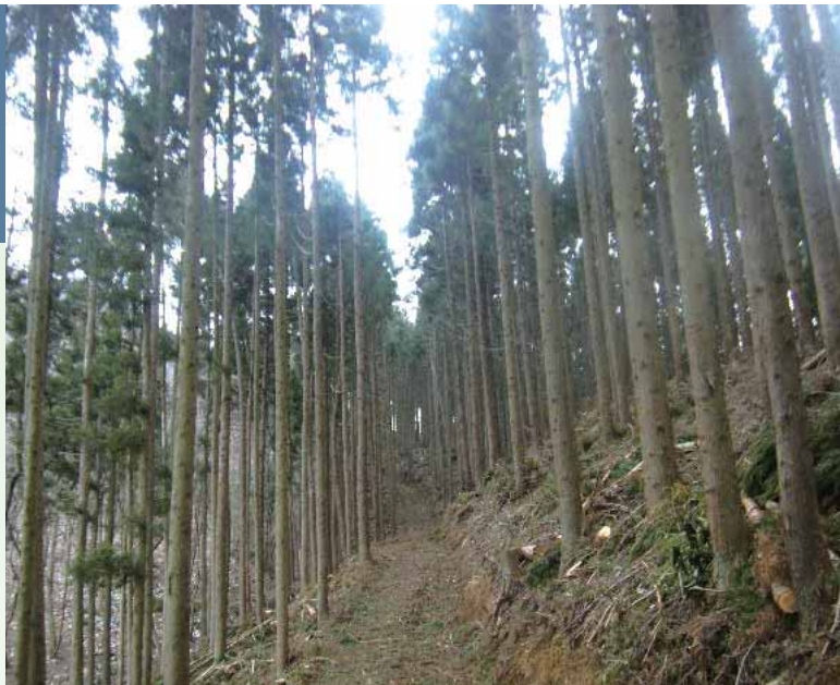
間伐作業が完了した現場
