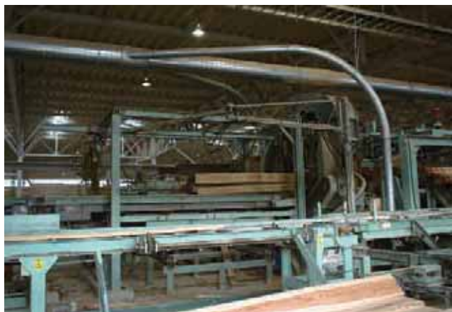
ツインバンドソーは3機を2シフトで稼働させている
